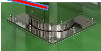
【 床面ケミカルアンカーボルト固定 】
